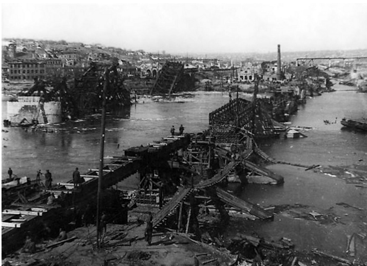
Разрушенный железнодорожный мост в Ростове-на-Дону, 1943 год
